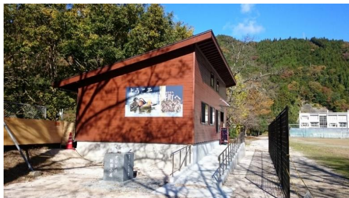
リニューアルオープンした オシドリ観察小屋
